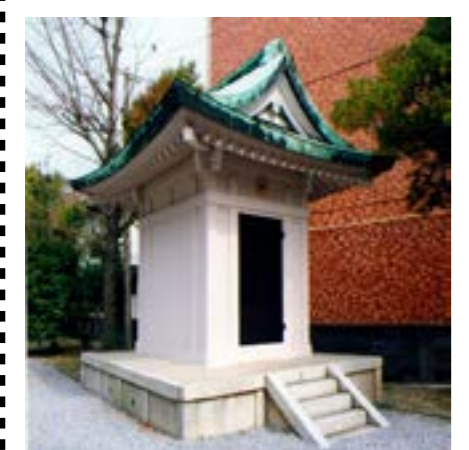
奉安殿（ほうあんてん）とは、戦前の日本において、全国の学校などの敷地内に設けられた特別な建物のことです。天皇・皇后の写真（御真影）と、教育勅語を火災や地震などの災害から守り、厳重に保管するために設置されました。
